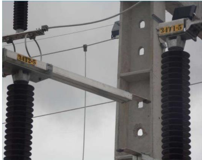
FIGURA 5 – Identificação da Chave Seccionadora tipo lâmina com dupla abertura lateral.
