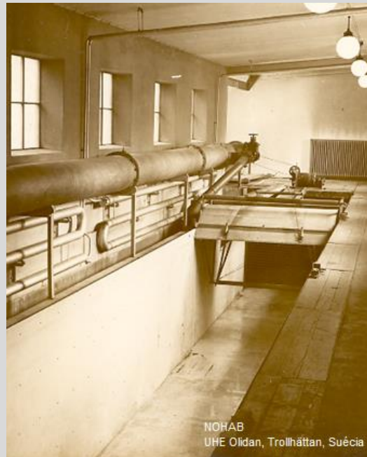
Medição de vazão (“traveling screen”)
