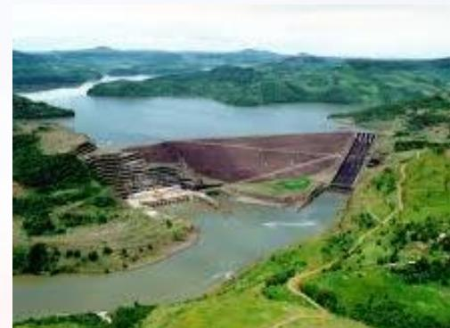
(b) **UHE GBM (Foz do Areia)**: Iguaçu, área de drenagem de 29.900 km<sup>2</sup>, área inundada de 139 km<sup>2</sup>, volume de 5.779 hm<sup>3</sup> e potência de 1.676 MW;
