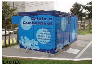
Sistema PAFC (200 kW) do LACTEC (Curitiba).
