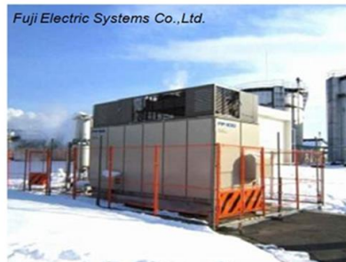
Sistema PAFC operando com biogás (Japão).
