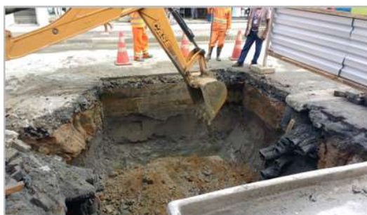
Figura 1(a) - Escavação na tipologia Americana.
