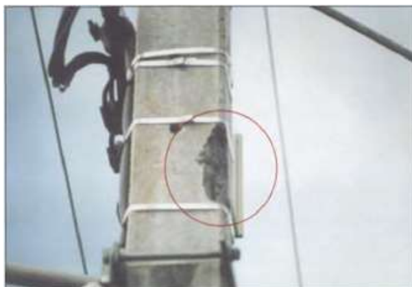
Figura 4 - Dano causado no poste por descarga disruptiva [7]
