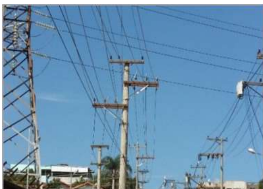
Figura 13(a) – Rede aérea com alta densidade de posteação.
