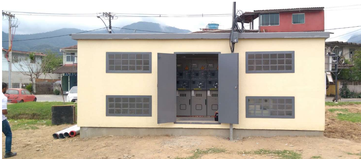
Figura 2(c) – Equipamentos abrigados em cabines de alvenaria na superfície na tipologia Enel.
