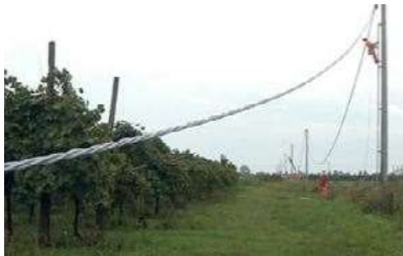
FIGURA 7 – Lançamento de um condutor isolado
