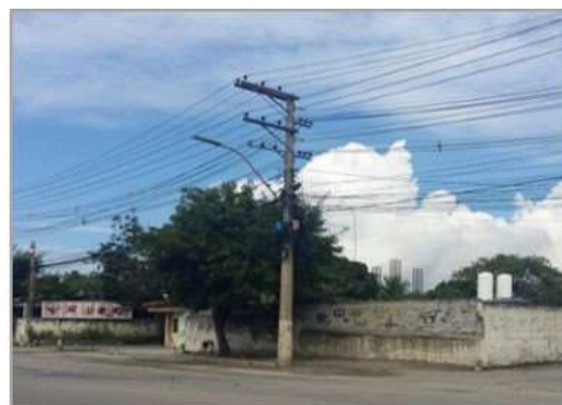
Figura 13(b) – Rede aérea com alta densidade de circuito.
