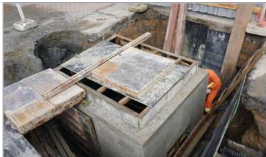
Figura 1(c) - Caixa de passagem na tipologia Americana.
