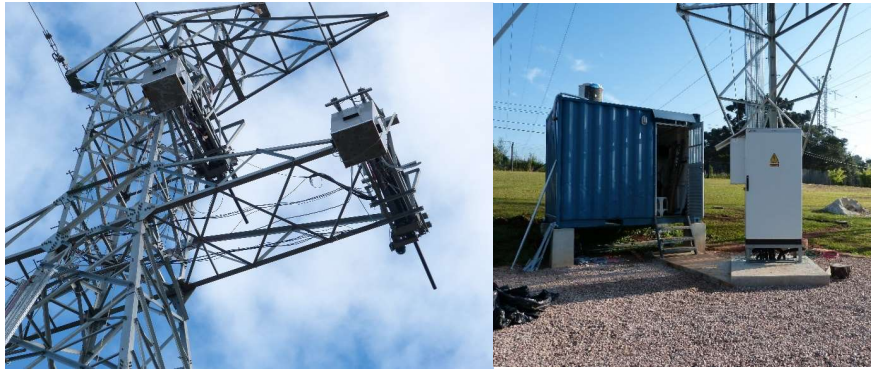
Figura 2 - Torre 1 com equipamentos instalados nas mísulas e sala de controle.
