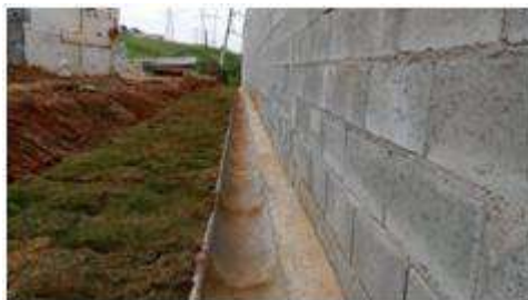
Figura 10 – Execução do sistema de drenagem.
