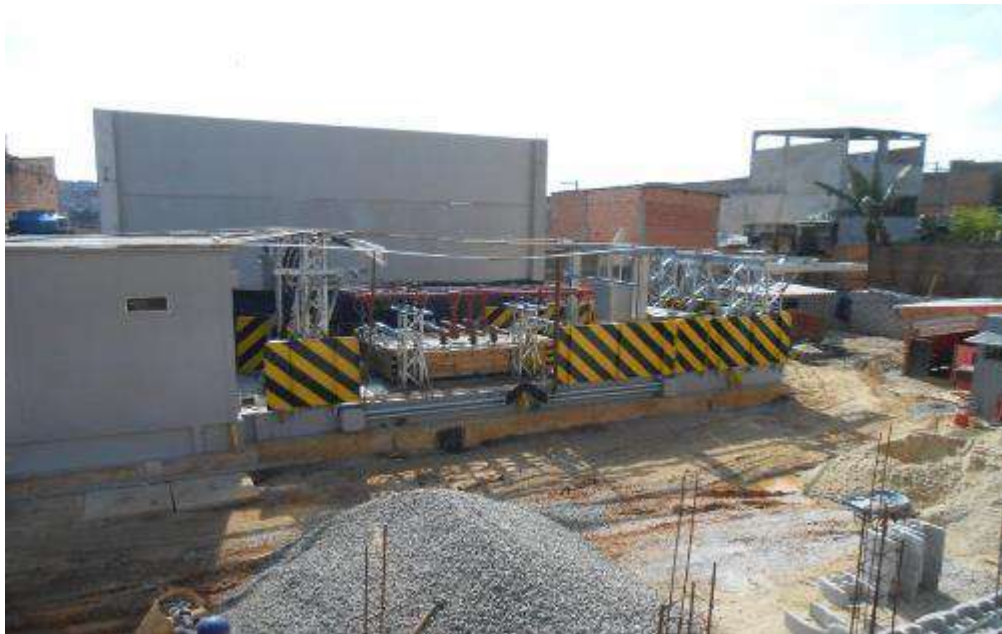
Figura 6 – Montagem da plataforma skid na base civil.
