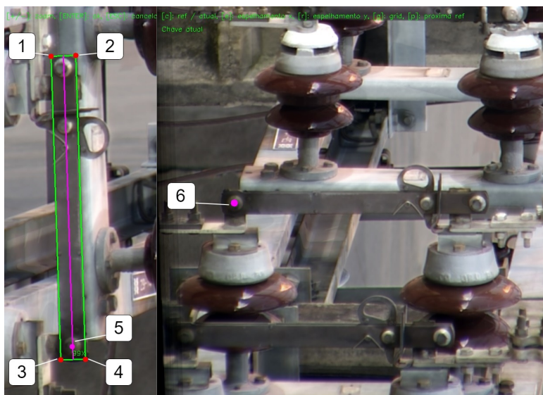
FIGURA 2 – Demarcação de uma chave seccionadora no software de rotulagem.
