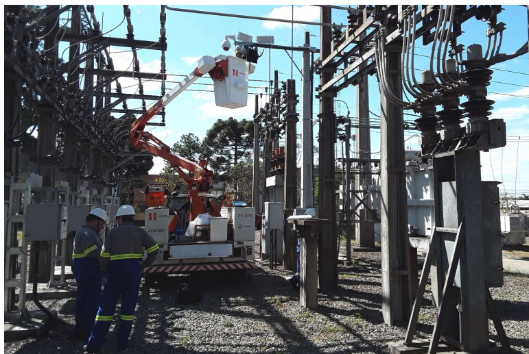
FIGURA 1 – Instalação de equipamento do projeto, poste, câmera e iluminador, na subestação.
