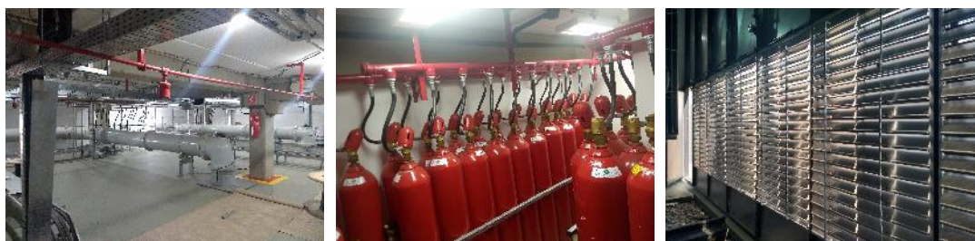
FIGURA 7 – Sistema de descarga de CO 2 , Baterias de CO 2 e dumpers de fechamento, respectivamente.
