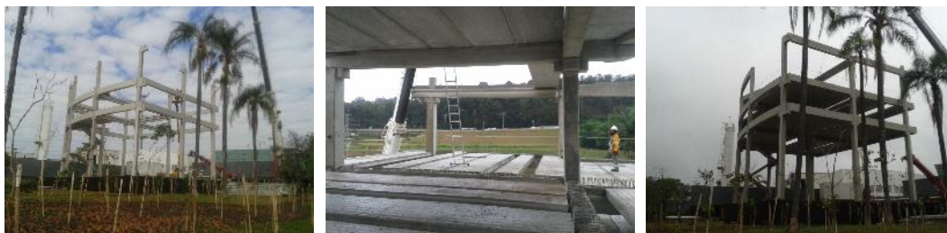
FIGURA 5 – Montagem das estruturas pré-moldadas.
