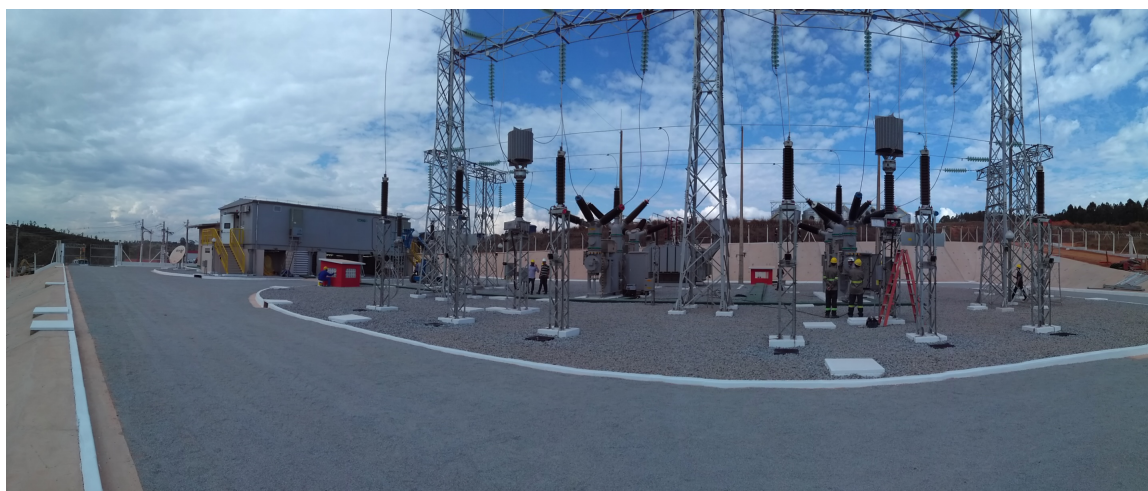
Figura 4 – SE Híbrida com 2 linhas e 1 Trafo
