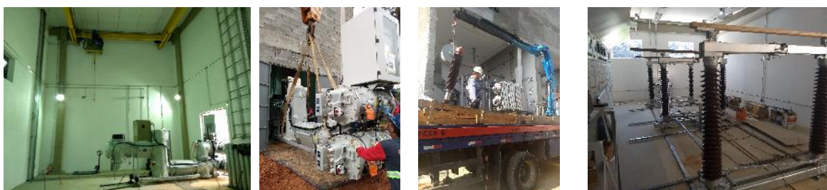
FIGURA 6 – Montagem do conjunto blindado GIS, buchas de alta tensão do transformador de potência e pré-montagem e ajuste da seccionadora, respectivamente.
