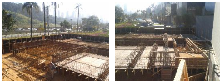
FIGURA 4 – Construção das bases em cima da laje do térreo.
