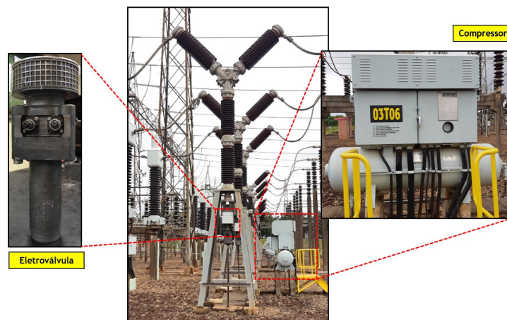
Figura 3 – Disjuntor de alta tensão típico da SE-MD (detalhe: estação de ar comprimido).
