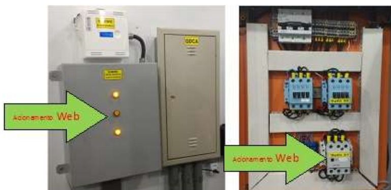
Fig. 6 – Quadro de Comando montado em campo.
