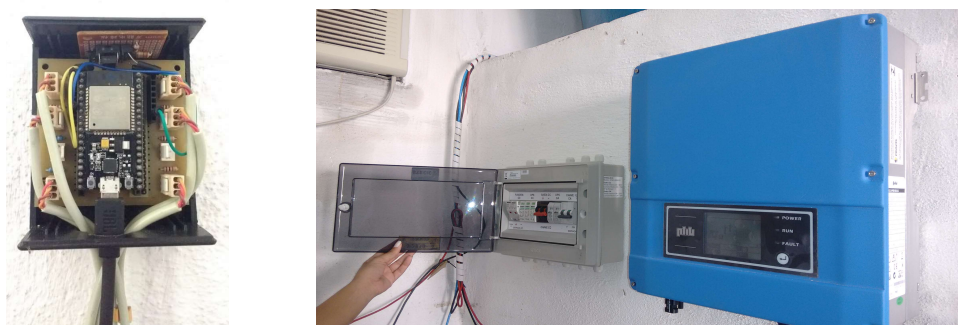
Figura 3 – Módulo IoT ESP 32, string box e inversor da planta FV de Fortaleza
