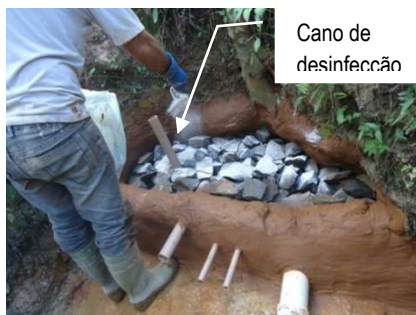
Figura17- Utilização de cal para desinfecção da caixa de proteção
