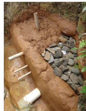
Figura18- Cobertura superior da caixa de proteção.
