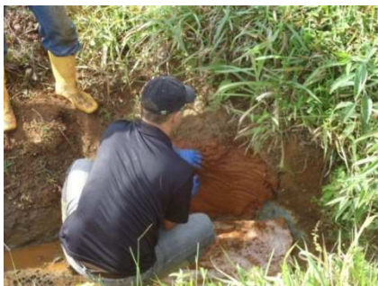
Figura11- Aplicação da massa solo-cimento na parede que reveste a nascente.
