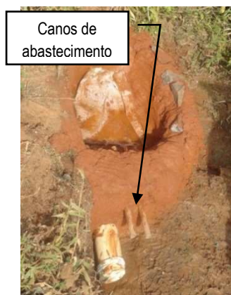
Figura13- Instalação dos canos de abastecimento.
