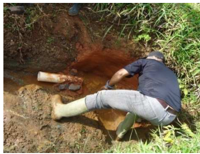
Figura12- Construção da prede frontal da caixa de proteção e assentamento do dreno de limpeza.
