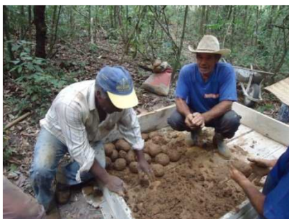
Figura9- Preparação da massa solo-cimento.
