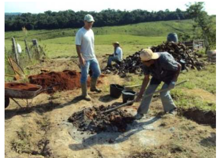
Figura8- Preparação da massa solo-cimento.
