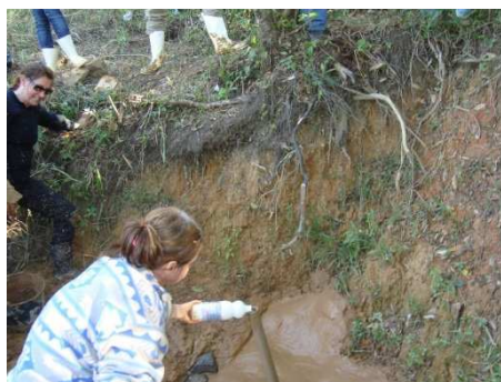
Figura20- Colocação de água sanitária para desinfecção da caixa de proteção.
