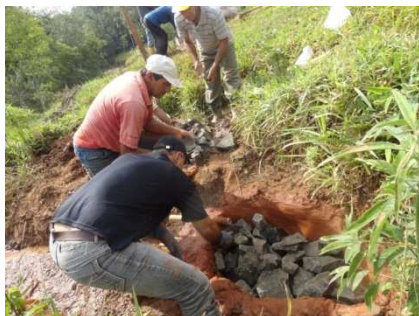
Figura16- Cobertura da caixa de proteção com pedra-ferro.
