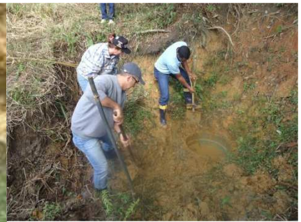
Figura5 - Retirada da estrutura inicial da nascente.
