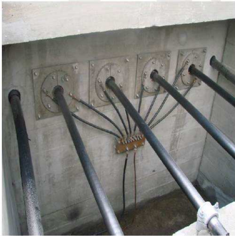
Figura 9: Detalhe do bloco de ancoragem e armação do cabo
