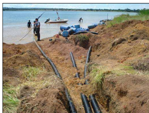
FIGURA 12 – Chagada dos cabos na transição.
