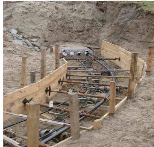
Figura 10: Detalhe do lançamento dos cabos no trecho subterrâneo
