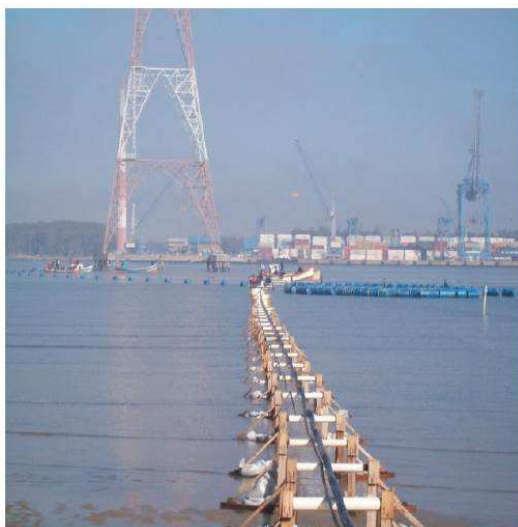
Figura 5: Etapa de lançamento do cabo
