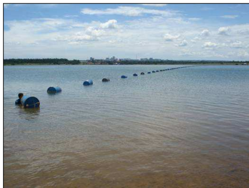
FIGURA 11 – Puxamento dos cabos com boias.
