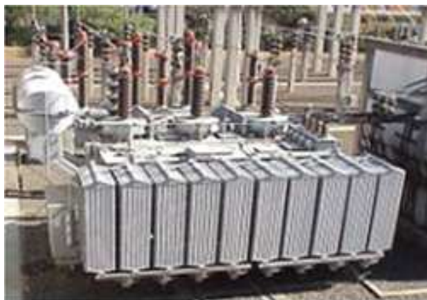
FIGURA 1 - Transformador de Distribuição Típico da CPFL. (Universo: Tensão: Alta 36,2 a 145 kV; Média 15 a 25 kV, Potência: 5 MVA a 60 MVA)
