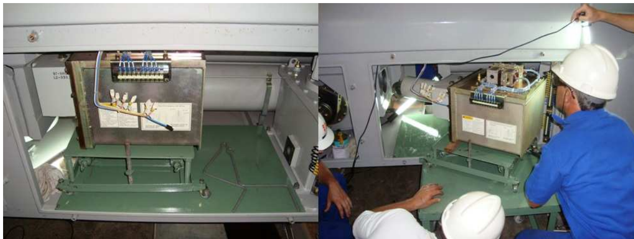
Figura 3 – Carrinho com macaco e mesa móvel para auxiliar a retirada e instalação do conjunto
