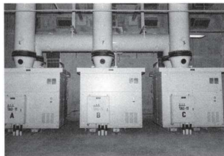
FIGURA 1 Cubículo de Excitación (Itaipu Binacional, 2005a).
