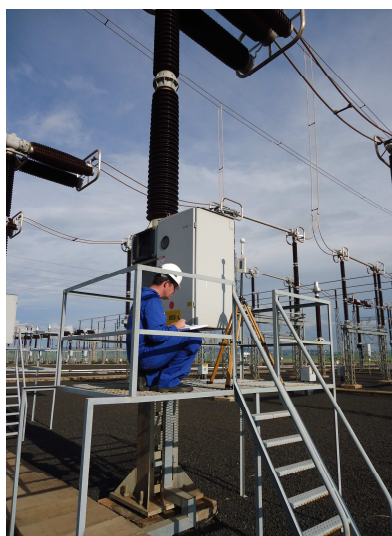
Figura 3: Os pontos onde as medições alcançaram níveis acima dos estabelecidos, foram realizadas sobre a plataforma de acesso aos mecanismos dos disjuntores.
