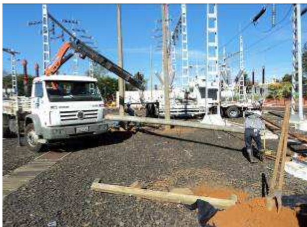
Figuras 5 e 6 - Instalação dos Postes de Concreto.
