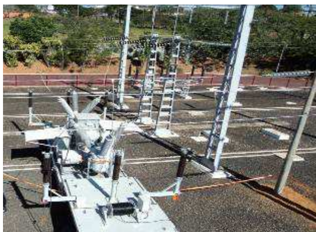
Figura 12 - Bay Móvel Conectado ao Barramento da Subestação.
