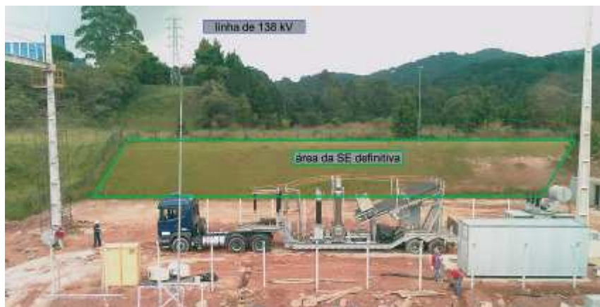
Figura 4 – instalação da bay móvel
