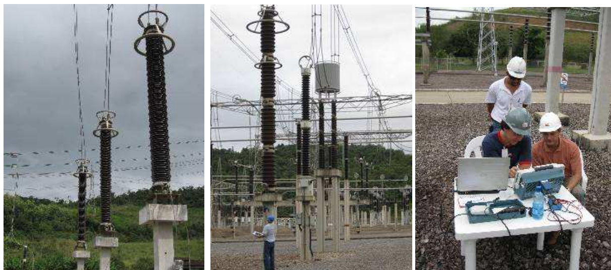
FIGURA 3 – Detalhes dos Pára-Raios, da Instalação do Sensor e da Equipe de trabalho
