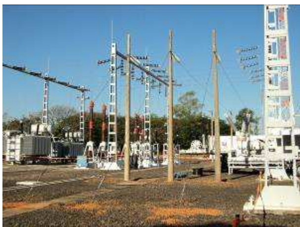
Figuras 7 e 8 - Barramento Provisório Instalado
