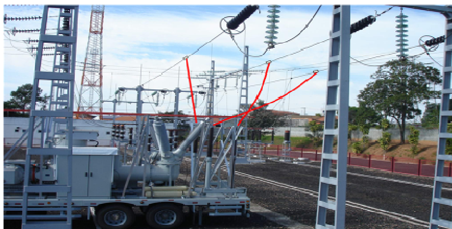
Figura 9 - Croqui da Conexão do Bay ao Barramento
