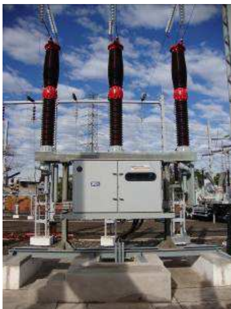
Figuras 19 e 20 - Novo Disjuntor, Tripolar e com Extinção a SF6.
