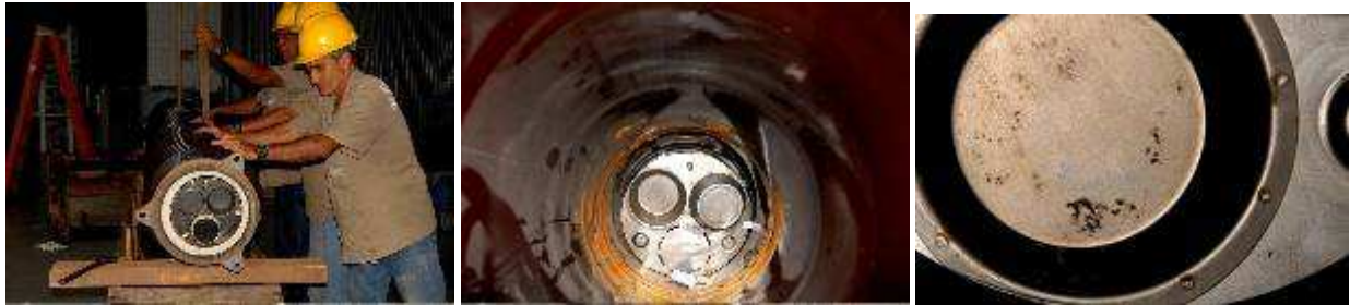
FIGURA 9 – Detalhes envolvendo a Abertura dos PR de 345kV e o estado interno dos mesmos
