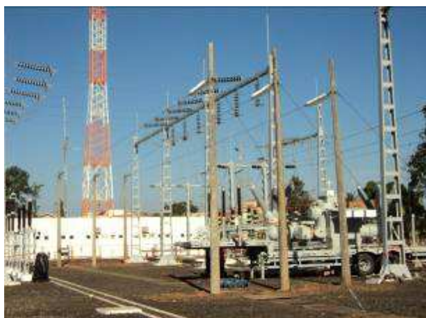
Figuras 7 e 8 - Barramento Provisório Instalado
