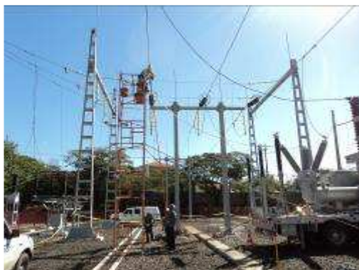
Figuras 10 e 11 - Serviços de Conexão com “Linha Viva”.
