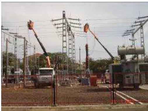
Figuras 17 e 18 – Desconexões para Retirada do Disjuntor Velho e Instalação do Disjuntor Novo.
