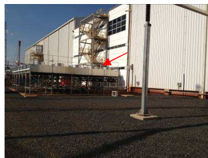
FIGURA 21 – Conjunto de radiadores externos
