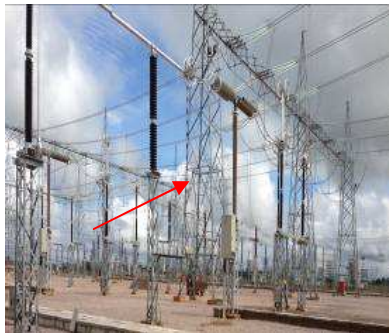
FIGURA 16 – Disjuntor com duas câmaras
