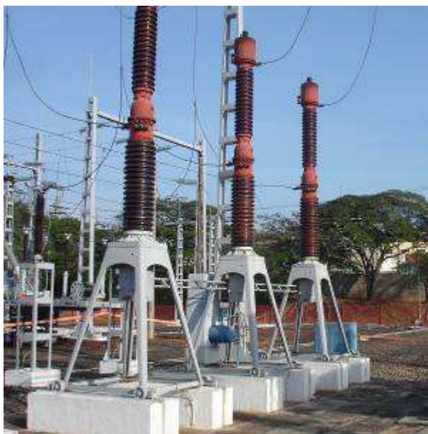
Figura 2 - Disjuntor Galileo, tipo Ocerd 150
