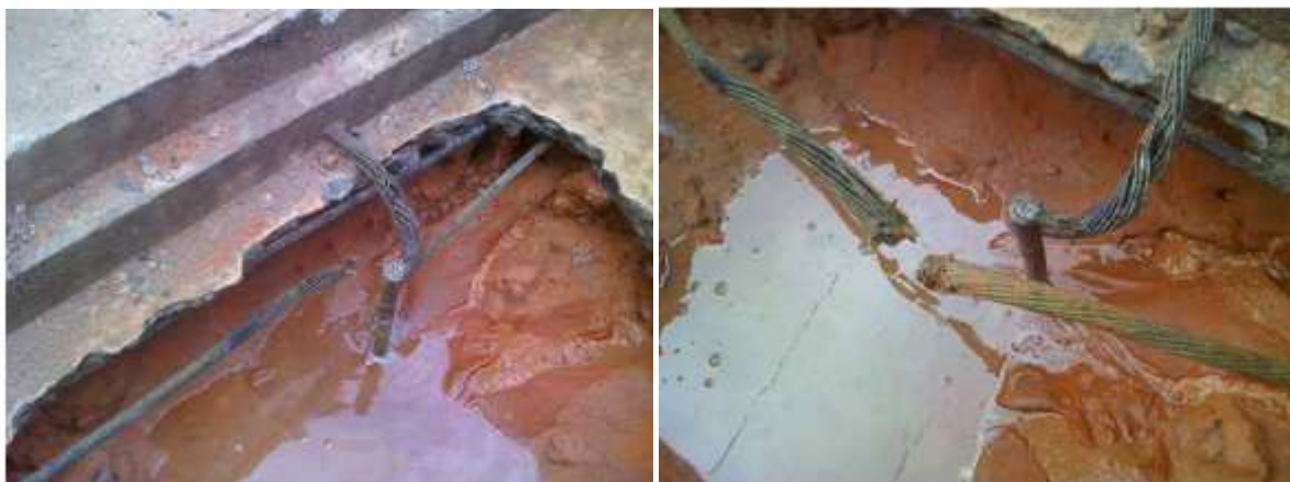
FIGURA 5 – Escavação e Comprovação de desconexão do reator 04E2 de Natal II
