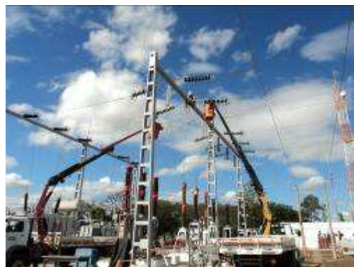
Figuras 17 e 18 – Desconexões para Retirada do Disjuntor Velho e Instalação do Disjuntor Novo.
