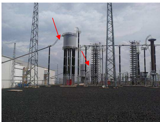
FIGURA 14 – Reatores de Alisamento
