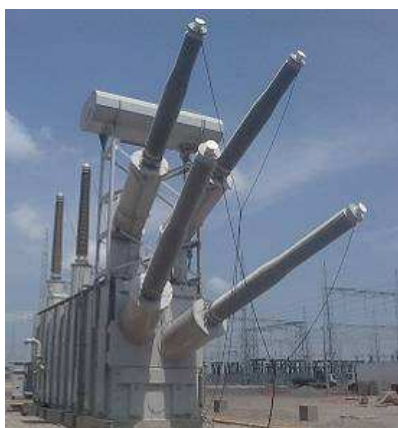
FIGURA 4 – Transformador Conversor Porto Velho
