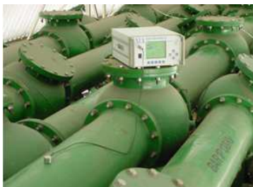
FIGURA 4 – AIA 1 acoplado a um sensor via cabo coaxial para a avaliação de barramentos isolados a gás SF 6 numa SIG de 138 kV [4]
