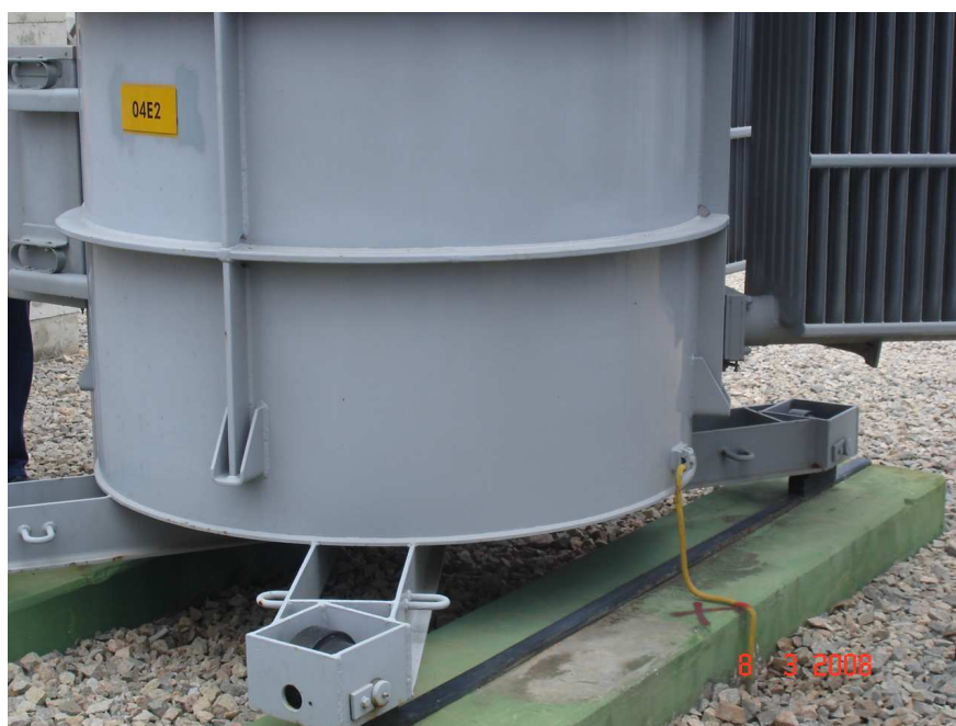
FIGURA 4 – Reator 04E2 de Natal II sob suspeita após medições
