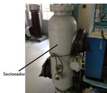
Fig. 11. Compartimento do seccionador a SF 6
