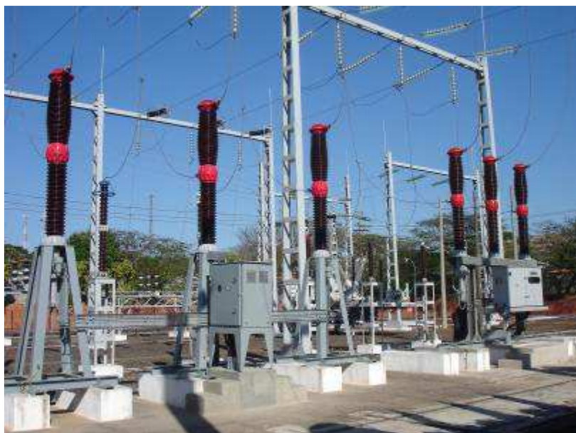
Figura 21 - Disjuntor Instalado, Inebrasa FA1-145KV, comando tripolar
