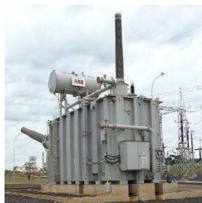
FIGURA 5 – Transformador Conversor Araraquara
