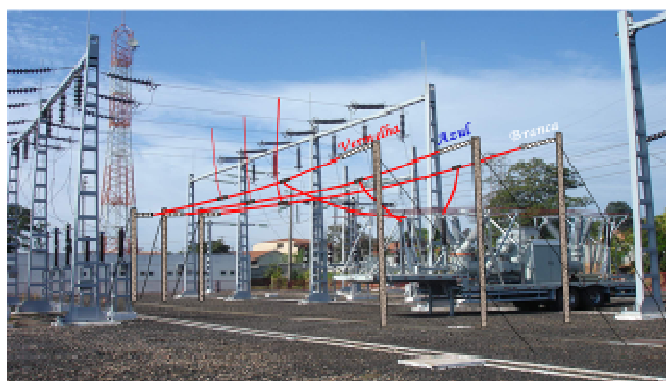
Figura 13 - Croqui das Instalações das Fases do Bay Móvel ao Barramento Provisório.
