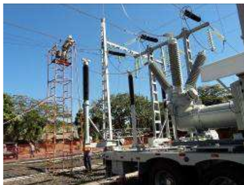
Figuras 10 e 11 - Serviços de Conexão com “Linha Viva”.
