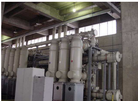
FIGURA 1 – Foto de uma SIG com os barramentos, disjuntores e outros equipamentos associados
