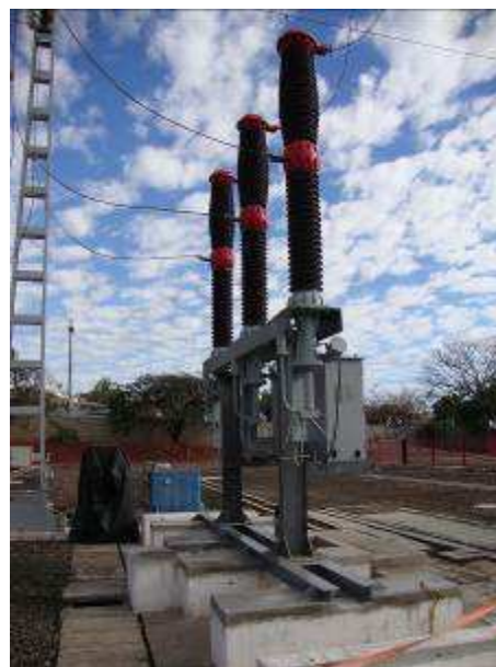
Figuras 19 e 20 - Novo Disjuntor, Tripolar e com Extinção a SF6.
