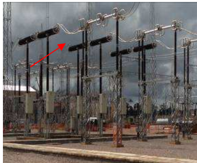
FIGURA 17 – Disjuntor com quatro câmaras
