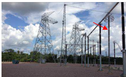
FIGURA 13 – Para-raios no pátio de CC
