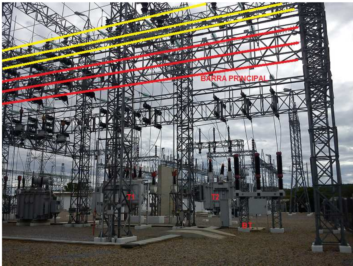
FIGURA 1 – Subestação Bom Nome – Barramento de 69 kV com vista da Interligação de barras BT, T1 e T2 a serem substituídos ao fundo.
