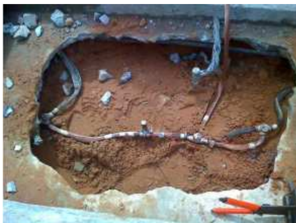
FIGURA 6 – Reparo da conexão do reator 04E2
