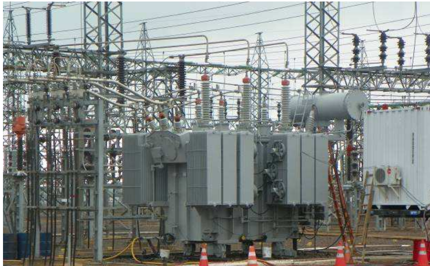
FIGURA 4. Transformador trifásico de 41MVA, 138kV/ 34,5kV /13,8kV utilizado como objeto de estudo
