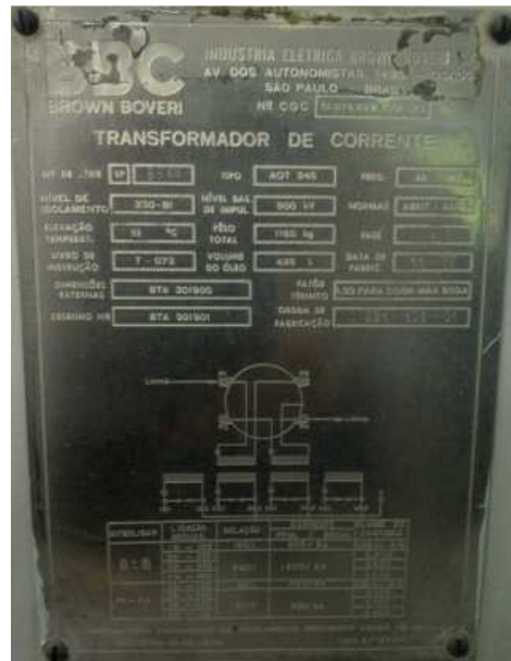
FIGURA 4 – Placa do Transformador em teste.
