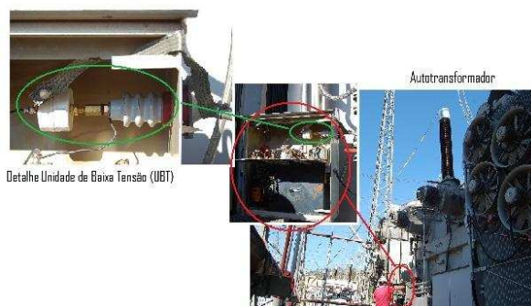
Figura 5b – Medição utilizando o tap capacitivo da bucha
