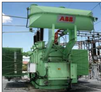
Figura 1 – Transformador de 25 MVA repotenciado com óleo vegetal
