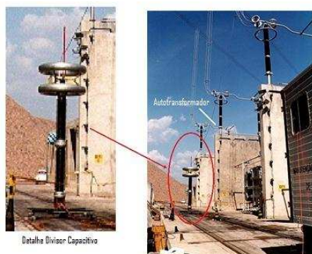
Figura 5a – Medição com Divisor Capacitivo [2]
