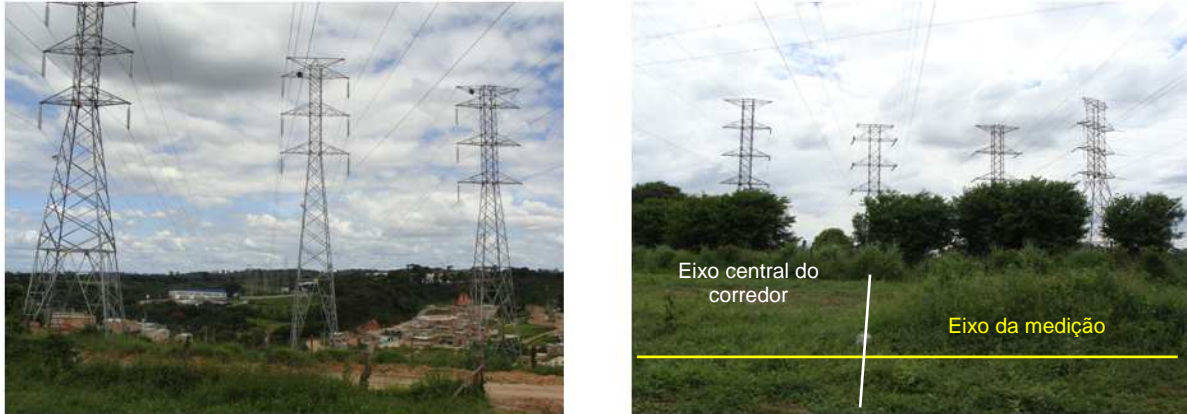
Figura 2 – Local em que foram realizadas medições de campo elétrico e magnético. O vão em questão possui um paralelismo de 5 linhas de 138 kV nas proximidades da SE Neves 1.
