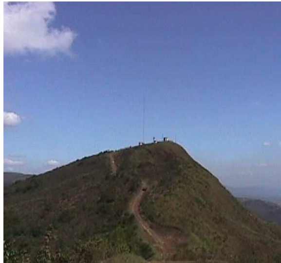
FIGURA 1 – Vista da Estação de pesquisa de descargas atmosféricas do Morro do Cachimbo com seu mastro de 60 m de altura e seu abrigo blindado.
