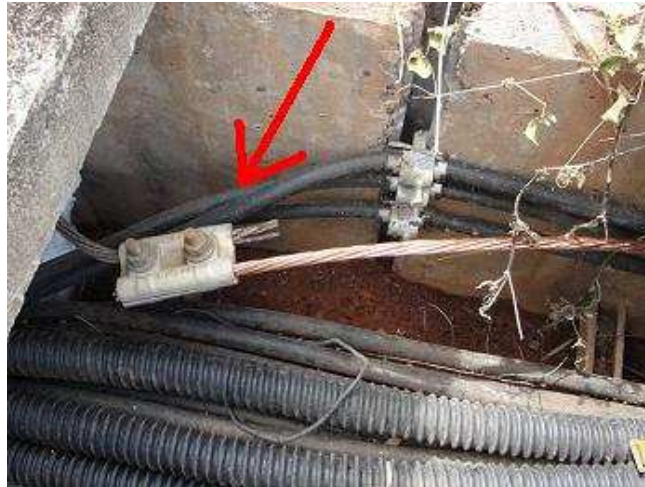
FIGURA 9 – FOTO DO LANÇAMENTO DE CABO PARA INTERLIGAÇÃO DAS MALHAS DE ATERRAMENTO DA CASA DE FORÇA A SE 500kV DE NOVA PONTE.
