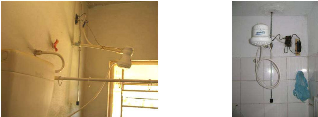
FIGURA 5 – Exemplos de instalação do chuveiro com o registro misturador
