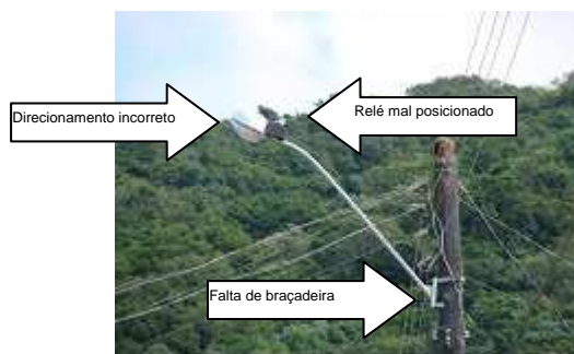
Figura 1 - Problemas de instalação verificados
