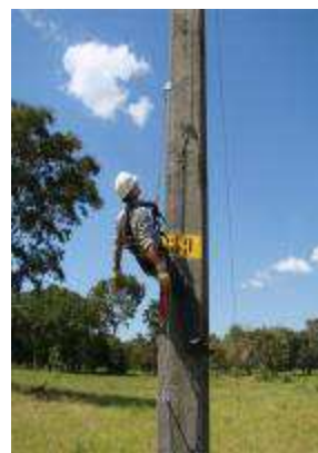
FIGURA 7 – (b) Eletrícista pendurado na linha de vida
