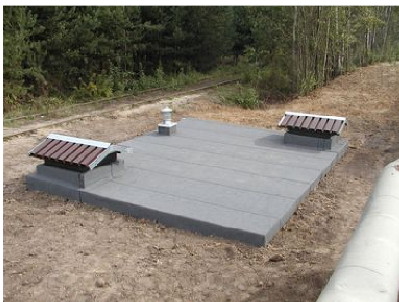
FIGURA 5– Vista da cobertura com pontos de ventilação de uma caixa de abrigo das caixas de Inox contendo as terminações.( Instalação na Polónia)
