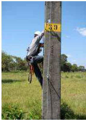
FIGURA 3 – Utilização de linha de vida e trava-quedas. FIGURA 4 – Utilização de linha de vida e trava-quedas.
