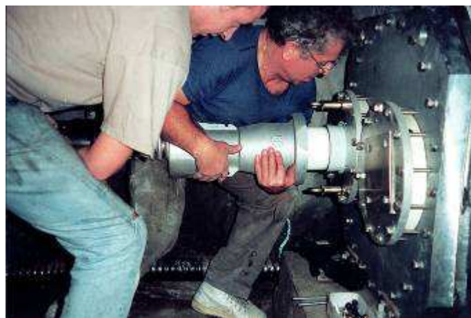
FIGURA 2 – Conexão da terminação do cabo na Emenda T
