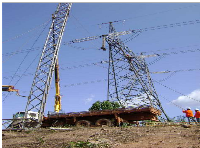
FIGURA 7 – Montagem da torre de emergência com o auxílio de dois caminhões munck.
