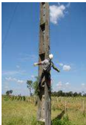
FIGURA 7 – (a) Eletrícista pendurado na linha de vida
