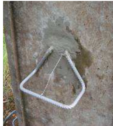
FIGURA 14 – Concretagem do estribo
