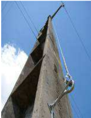
FIGURA 8 – (a) Linha de vida fixada
