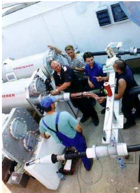
FIGURA 1 – Instalação do Conector macho desconectável no cabo antes da operação de “plug-in” na Emenda T na Linha entre a Usina de Belchatów e a Subestação Kleszczów (Polônia)
