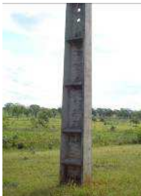
FIGURA 9 - Dificil acesso para chegar aos buracos situados no meio do cocho do poste
