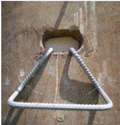
FIGURA 13 – Instalação do estribo
