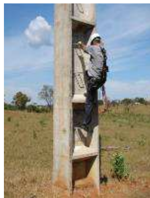
FIGURA 17 – (b) Escalada com utilização do estribo
