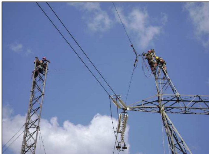
Figura 8 – Deslocamento do cabo OPGW da torre de ancoragem para a torre de emergência.
