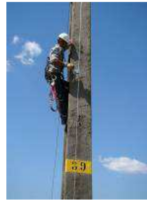
FIGURA 3 – Utilização de linha de vida e trava-quedas. FIGURA 4 – Utilização de linha de vida e trava-quedas.
