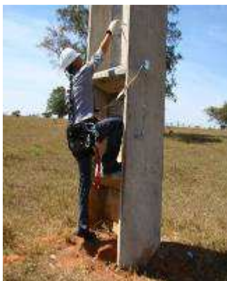
FIGURA 17 – (a) Escalada com utilização do estribo
