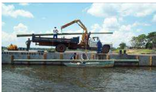
FIGURA 5 –(a) – Postes retirados da balsa e colocados em lancha
