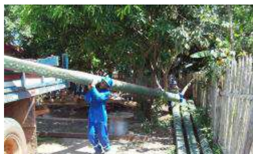
FIGURA 5 –(d) – Poste sendo colocados no caminhão
