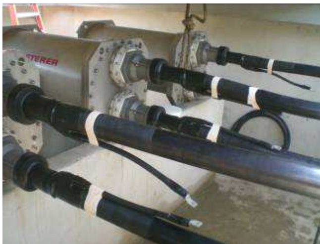
FIGURA 4– Caixa de Inox contendo as terminações, montada sobre estrutura de alvenaria
