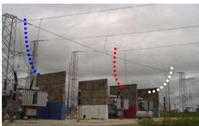
FIGURA 14 – Pingados que serão retirados das buchas do ATR1
