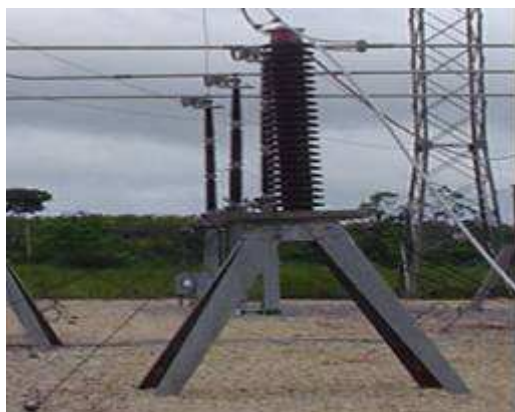
FIGURA 12 – Suporte com coluna isolante
