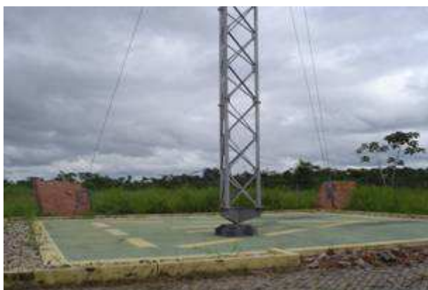
FIGURA 13 – Blocos de concreto
