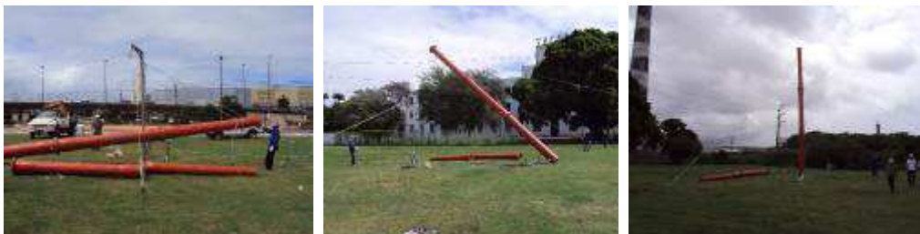
FIGURA 7 – Içamento do poste.
