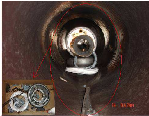
Figura 12 – Peças do Sistema de Extinção Arco
