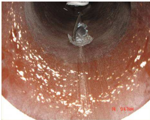
Figura 14 – Esmalte interior da câmara danificado
