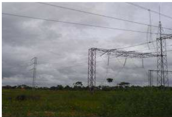
FIGURA 11 – Vista do ramal conectado na torre de emergência e no pórtico de 230 kV
