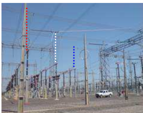
FIGURA 3 – Preparativos para conexão do ramal na barra de 500 kV e pingados que serão retirados
