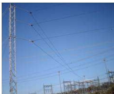
FIGURA 6 – Saída do ramal da barra de 230 kV em direção a torre estaiada
