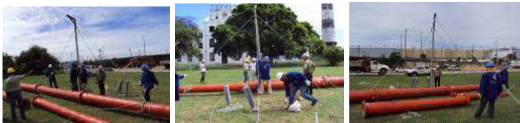
FIGURA 6 – Instalação do Pau de Carga.
