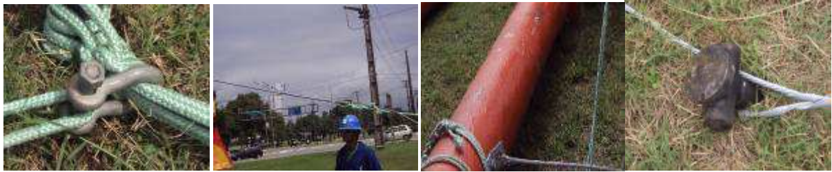
FIGURA 5 – Conexão dos estais.
