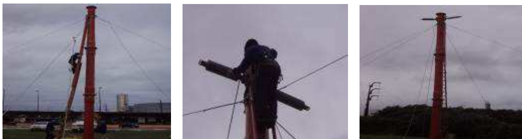
FIGURA 8 – Instalação dos isoladores.
