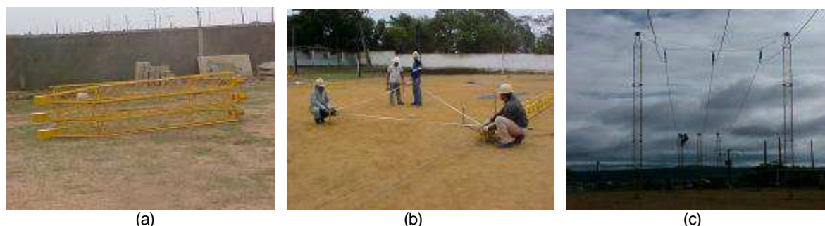
FIGURA 1 – Estrutura de emergência de ferro: (a) Módulos treliçados de 4m. (b) Procedimento de montagem. (c) Estrutura montada.
