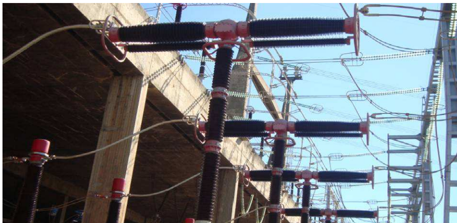
Figura 1 – Vista dos Disjuntores principais da Unidade Geradora – UHE JUPIÁ.
