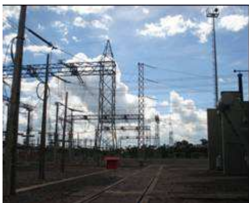
FIGURA 5 – Saída do ramal da barra de 500 kV em direção a torre estaiada
