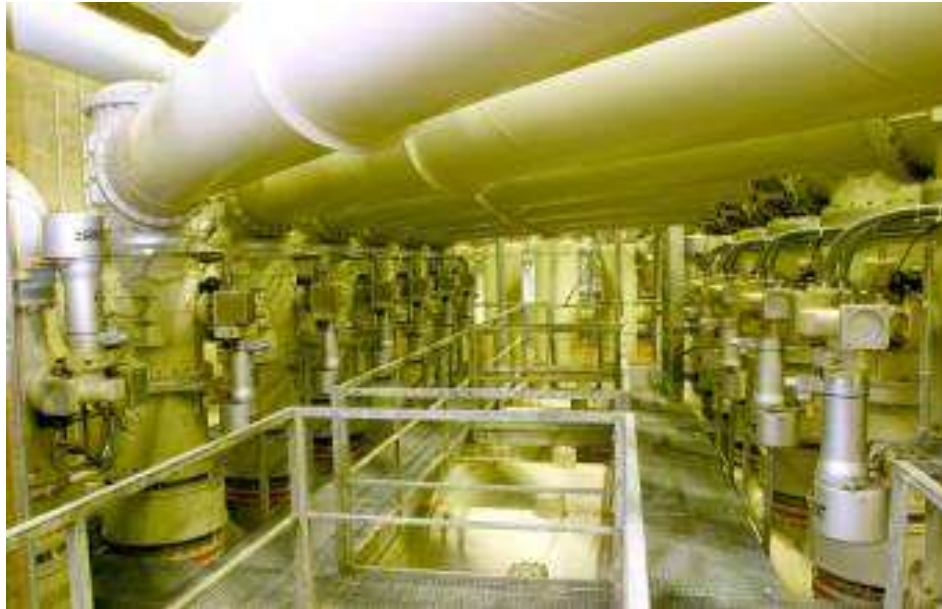
FIGURA 2 – Vista parcial de um bay típico da GIS
