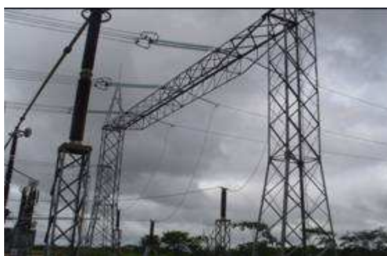
FIGURA 9 – Ramal passando por baixo da barra de 500 kV e ancorado no pórtico
