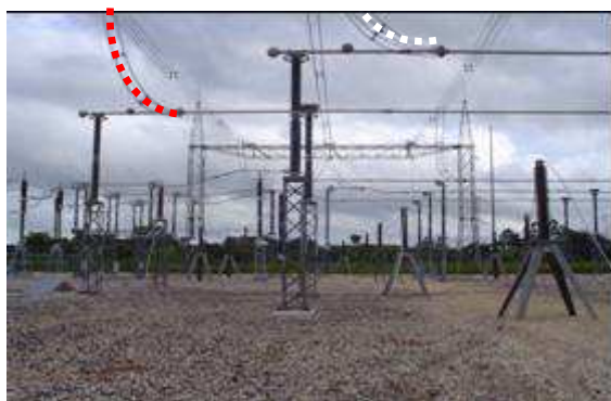
FIGURA 8 – Preparativos para conexão do ramal na barra de 500 kV e pingados que serão retirados
