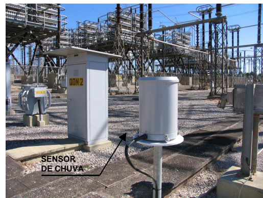
FIGURA 4 – Sensor de chuva instalado no interior da área energizada da subestação de Itaberá-SP.
