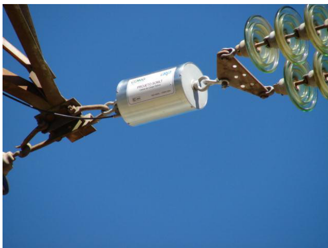
FIGURA 4 - Detalhe da instalação da célula óptica em estrutura de ancoragem de linha aérea 138kV da Cemig D.
