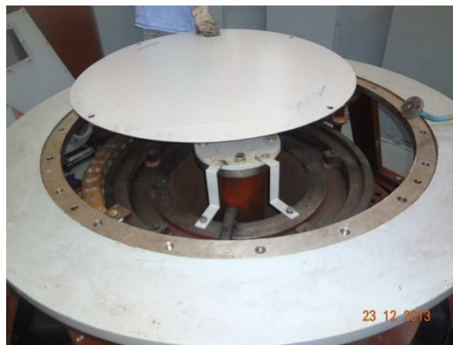
FIGURA 7 – Travamento dos tubos de comando.
