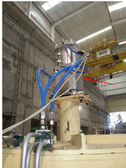
Figura 12 – Detalhe da válvula pneumática instalada
