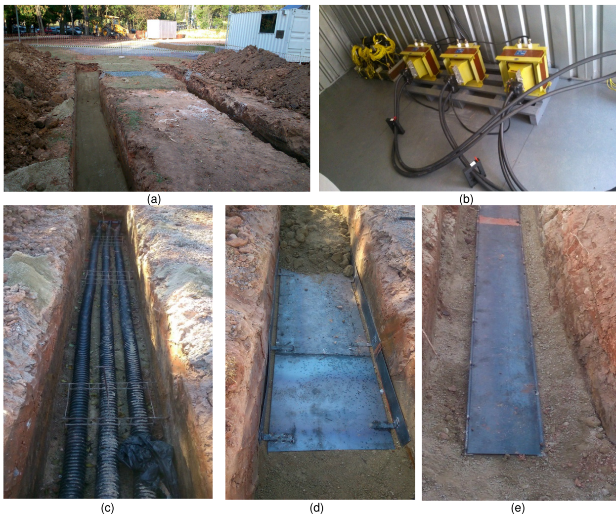
FIGURA 3 – Fotos da construção do campo de testes e do protótipo experimental: (a) Valas dos trechos de linhas subterrâneas; (b) Transformadores de energização do circuito; (c) Cabos dispostos na vala; (d) Chapa em "H"; (e) Canaleta de aço fechada enterrada A técnica de compensação por loops passivos baseia-se na instalação, ao lado do circuito principal da linha, de
