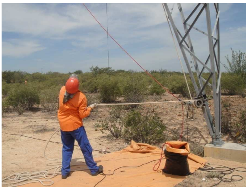
Figura 7 – Mantenedor içando material com auxílio da talha elétrica
