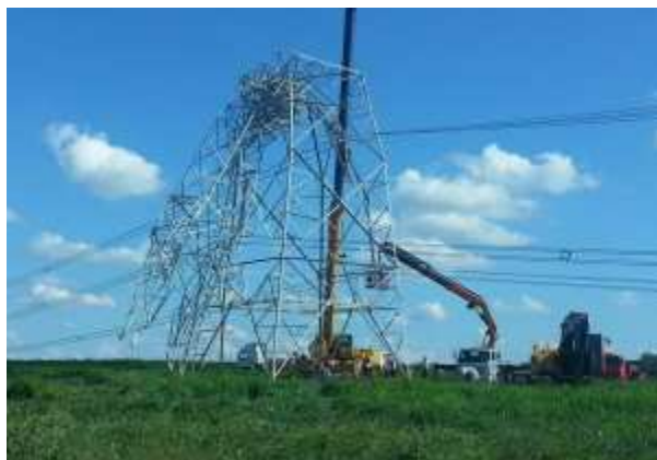
FIGURA 5 – Danos na Torre 332 – Margem esquerda
