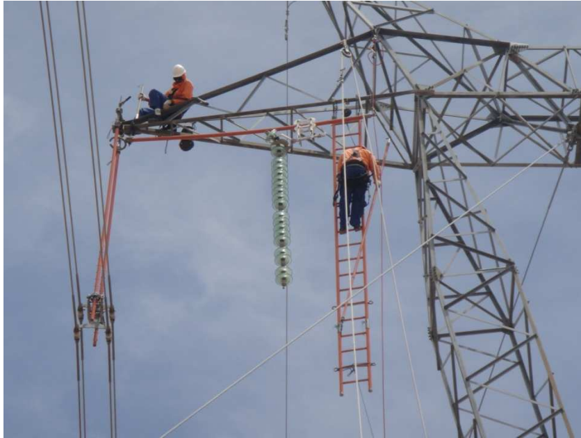
Figura 8 – Deslocamento da cadeia de isolador completa pelo trilho
