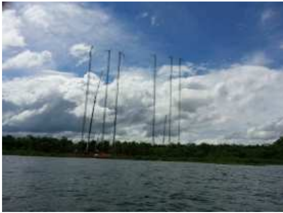
FIGURA 12 – Montagem das estruturas de emergência na configuração ancoragem de 72 metros de altura
