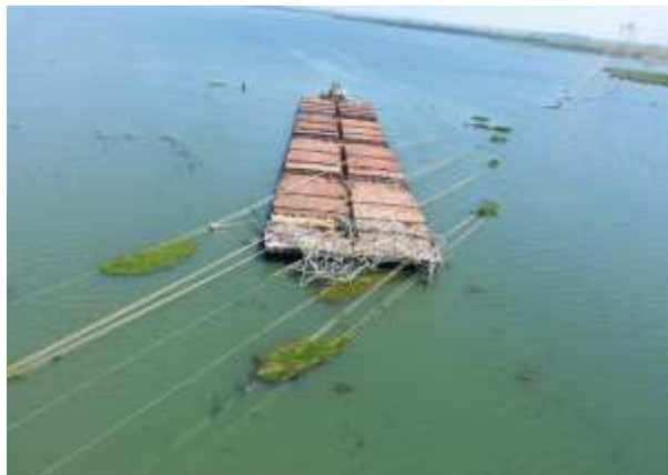
FIGURA 2 – Vista da Colisão da Balsa com Torre 331
