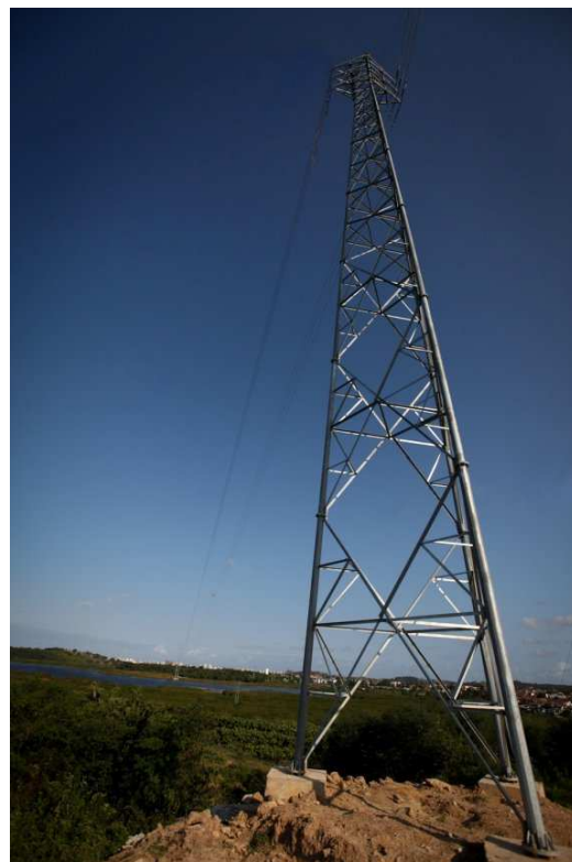
FIGURA 7 – Torre Triangular de Transmissão – LT 69 kV Jardim – Contorno – Energisa Sergipe – Aracaju – SE – somente os montantes são tubulares
