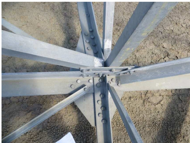
FIGURA 02 – Detalhe de uma ligação excêntrica complexa
