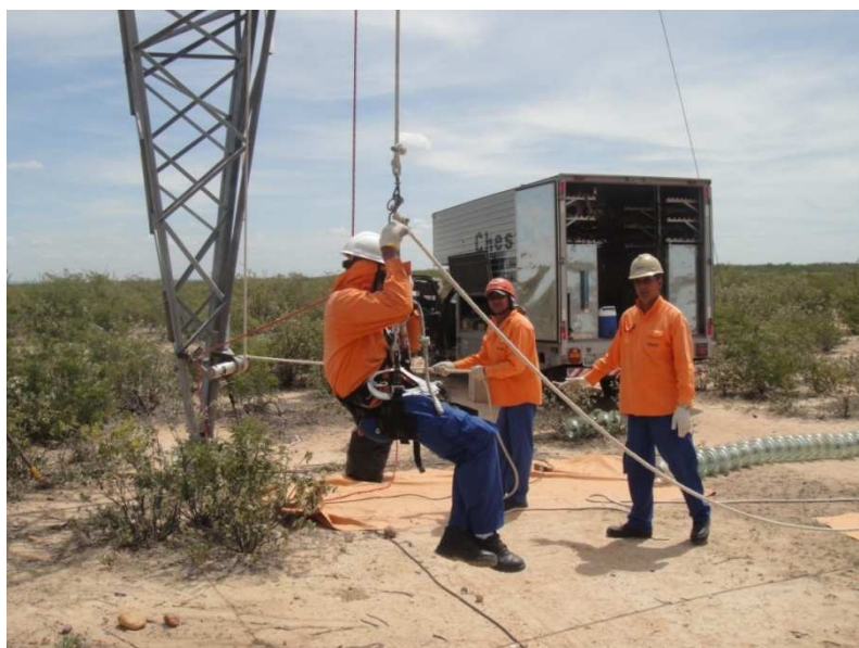
Figura 5 – Mantenedor sendo içado ainda no final do solo
