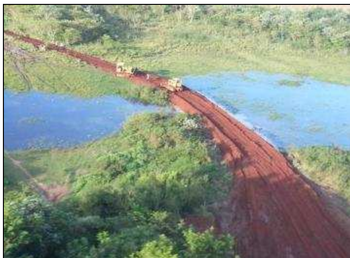
FIGURA 11 – Vista aérea: Construção do acesso entre a margem e a ilha possibilitando a passagem de equipamentos pesados
