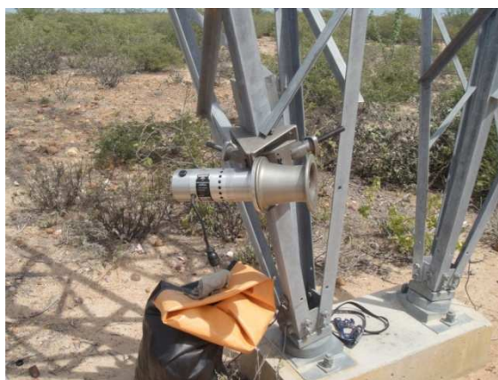
Figura 4 – Talha Elétrica acoplada na base da estrutura
