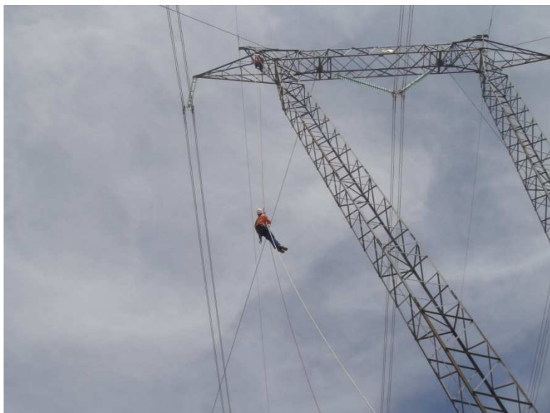
Figura 6 – Mantenedor sendo içado quase no alto da estrutura
