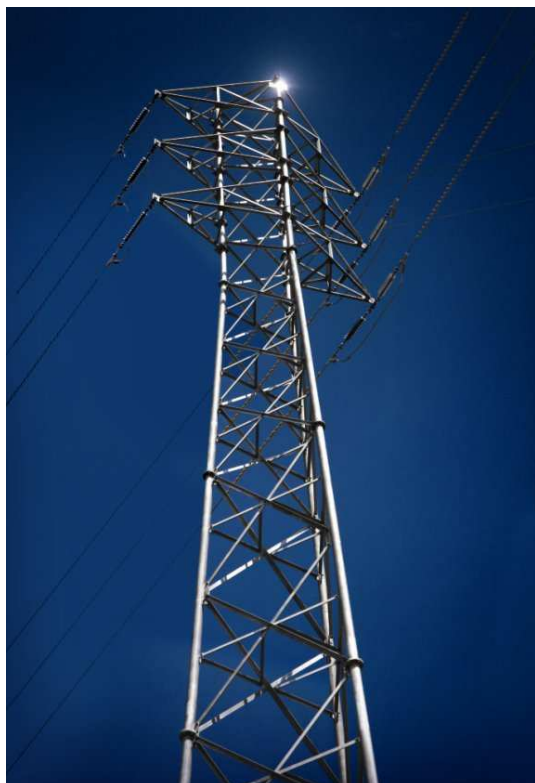
FIGURA 7 – Torre Triangular de Transmissão – LT 69 kV Jardim – Contorno – Energisa Sergipe – Aracaju – SE – somente os montantes são tubulares
