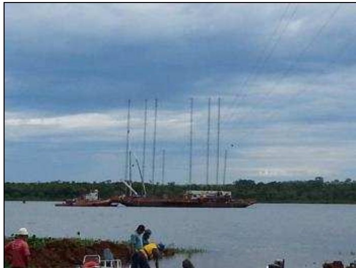
FIGURA 14 – Apoio dos guindastes embarcados nas balsas para lançamento dos cabos condutores
