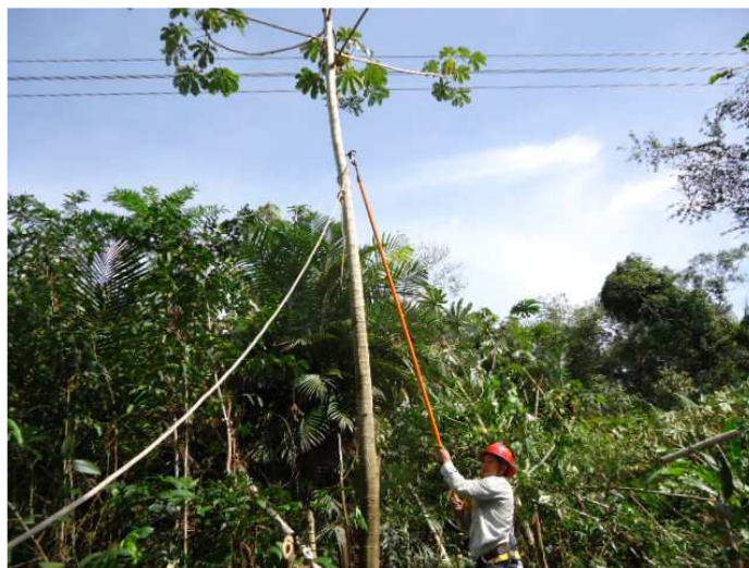
FIGURA 5 – Metodologia de linha viva desenvolvida pela Abengoa / Omega Brasil para a região Amazônica.
