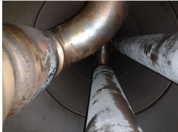
Figura 7 – Foto Trecho da Barra 3 A contaminado.
