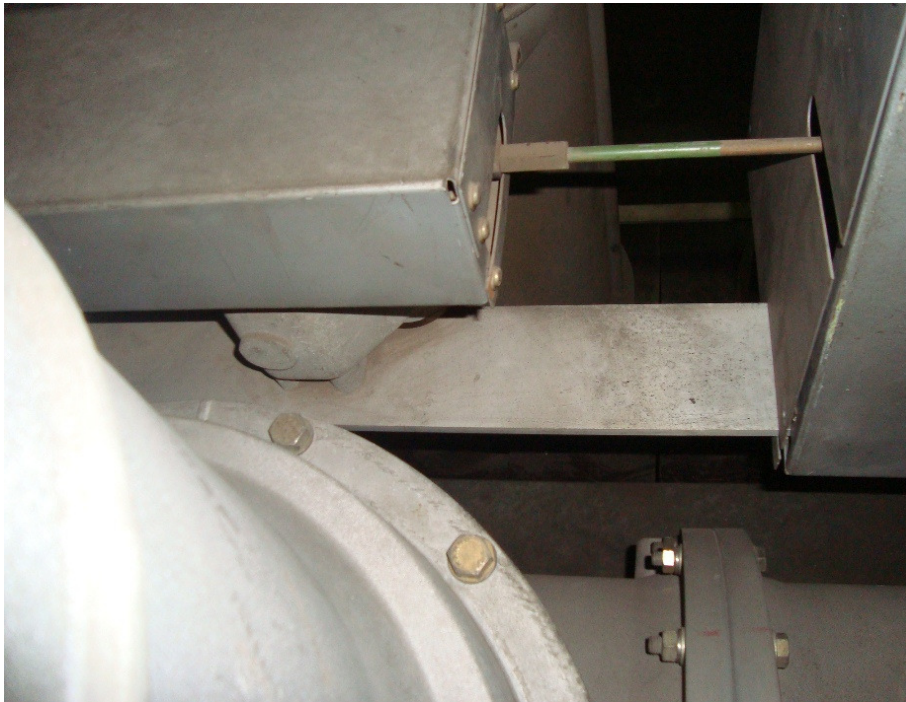
Figura 3 – Sinalização do seccionador de aterramento rápido 36829-93 do bay TRAT-2.
