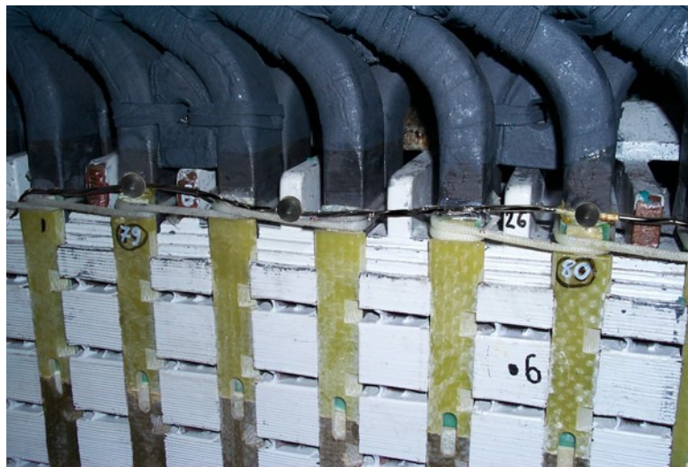
Figura 12: Sensores de temperatura instalados nas barras do estator de um hidrogerador
