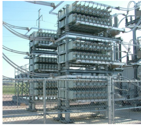
FIGURA 10 - Banco de capacitores com sol no lado direito
