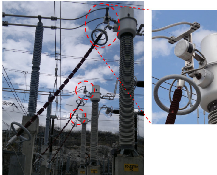
Figura 3 – Sensores ópticos dos TCs na subestação MMT
