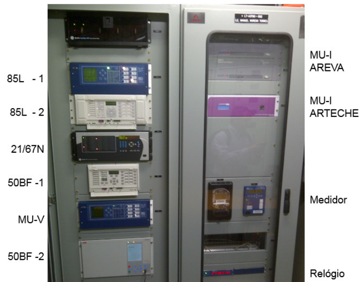
Figura 5 – Painéis com IEDs na Subestação MMT
