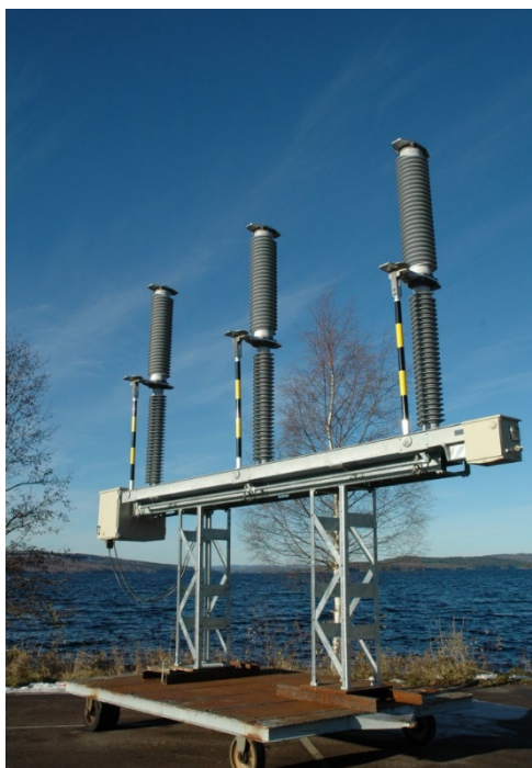
Figura 3: DCB : disjuntor e chave de aterramento motorizada
