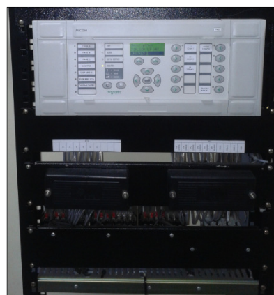
Figura 4: Pedestal com relé digital
