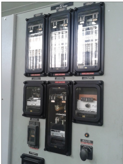
Figura 11: Pannel proteção e controle AT-2
