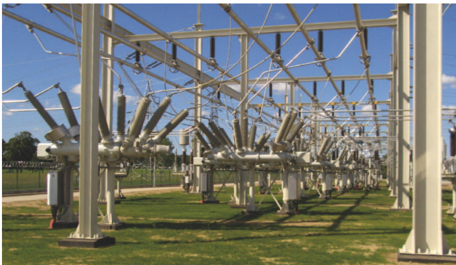
Figura 1 – Subestação arranjo barra dupla com módulo híbrido[3]
