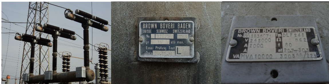
Figura 2: Disjuntores BBC DLGF 245 e DLF 245 – Fabricação 1971
