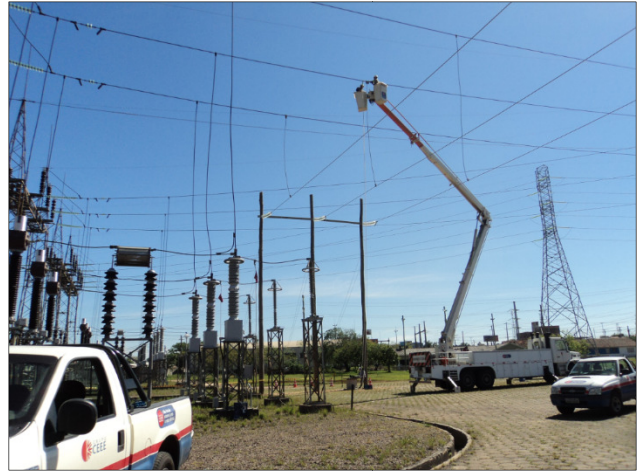
Figura 8: Conexão entre FT Gravataí 2 C4 e FT AT-2 através do barramento temporário 3
