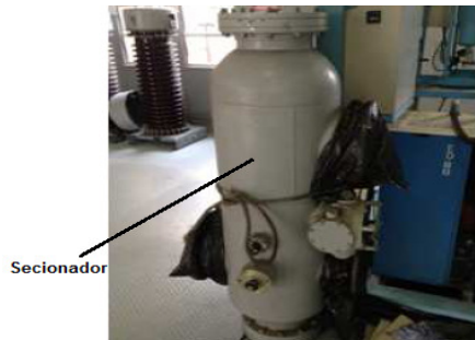
FIGURA 7– Compartimento do seccionador a SF 6
