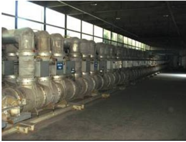
Figura 3: Vistas do conjunto blindado GIS instalado na subestação.
