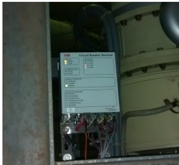
FIGURA 1 – Local de instalação das remotas CBS
