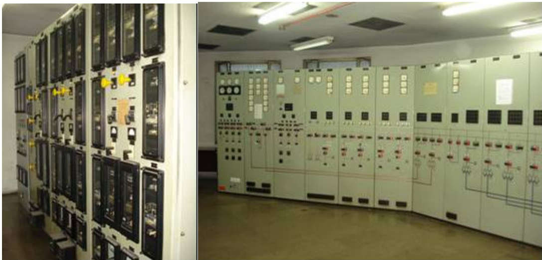
Figura 4: Vistas dos painéis de proteção e comando instalado na subestação.
