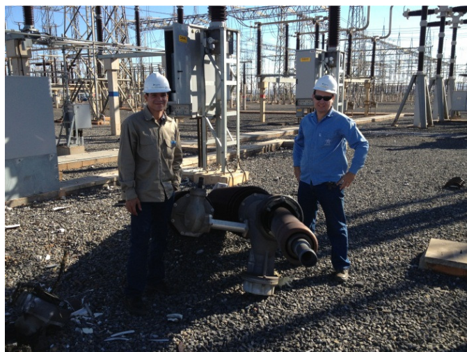
Figura 2 - Câmara da fase A explodida e câmara adjacente da mesma fase.
