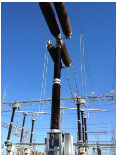
Figura 1 – Disjuntor de 362 kV – Comando a mola – Meio de extinção do arco a SF6
