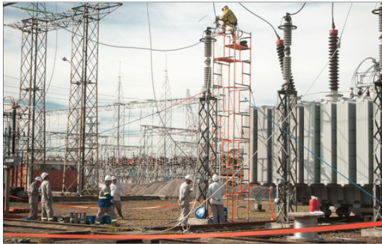
Figura 15: Serviço de linha viva ao potencial – barramento temporário 4
