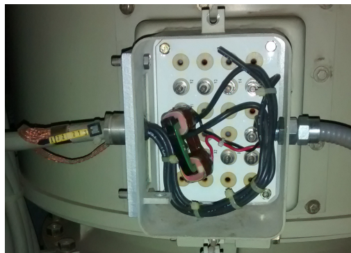
FIGURA 2 – CT Clamper instalado na caixa de terminais
