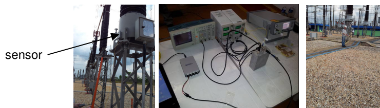
FIGURA 6 - Sensor instalado no TC 702 _V do DJ701, telemetria integrada e distância do TC à casa de relés.
