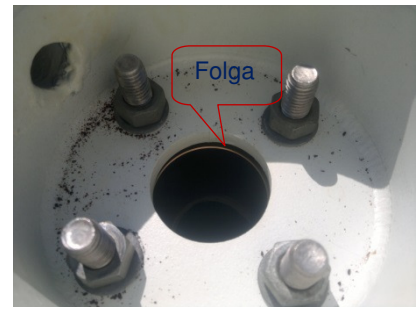
FIGURA 11 – Conexão da bolsa com tubulação do secador, mostrando folga de ~4mm.
