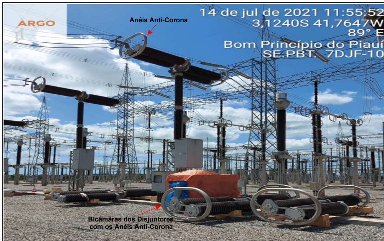
Figura 8 – Instalação em Campo dos Anéis Anti-Corona nos Disjuntores Bicamaras de 500 kV
