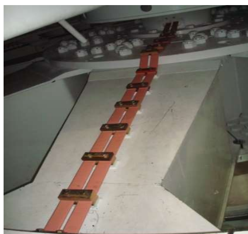
FIGURA 2: Secção Barra DC de interligação do Anel coletor aos pólos
