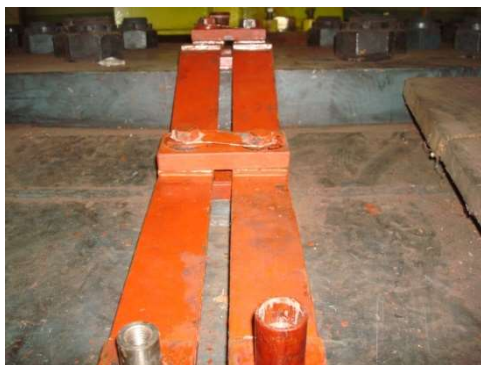
FIGURA 8: Fixação das Barras DC com parafuso no orifício da barra DC
