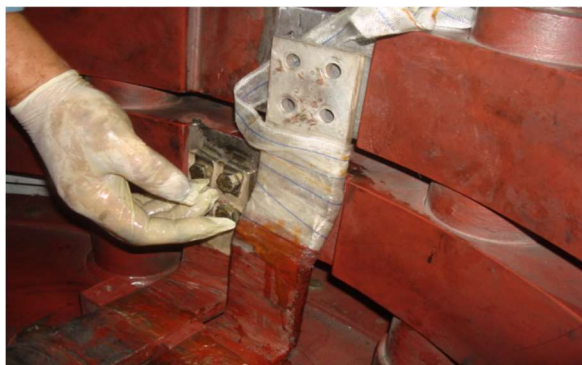
FIGURA 5: Re-isolação da Barra DC
