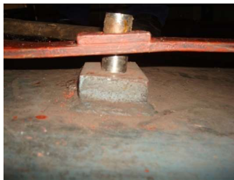
FIGURA 9: Fixação das Barras DC com parafuso no orifício da barra DC (Sem Isolador).
