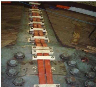
FIGURA 12: Montagem completa da barra DC
