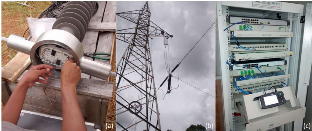
FIGURA 2 - Construção da LAS para testes na UniverCemig: (a) realização das emendas na base do isolador óptico e elétrico 138 kV, (b) instalação do arranjo com o condutor OPPC e (c) rack com as terminações das fibras ópticas e os equipamentos da rede óptica, CWDM e OTDR, na central de controle.
