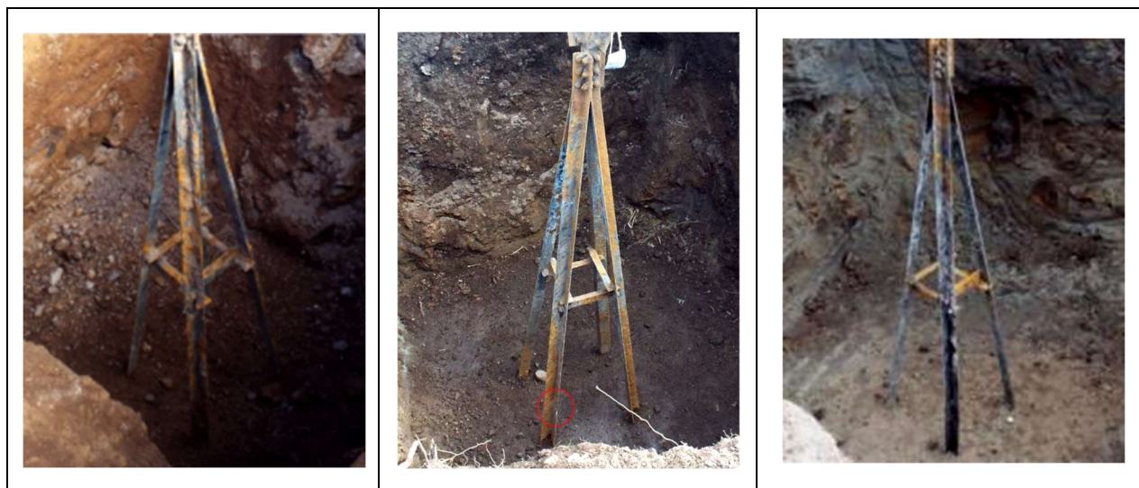
Figura 4 – Aspecto visual do aço galvanizado enterrado de algumas torres inspecionadas na CGT Eletrosul.
