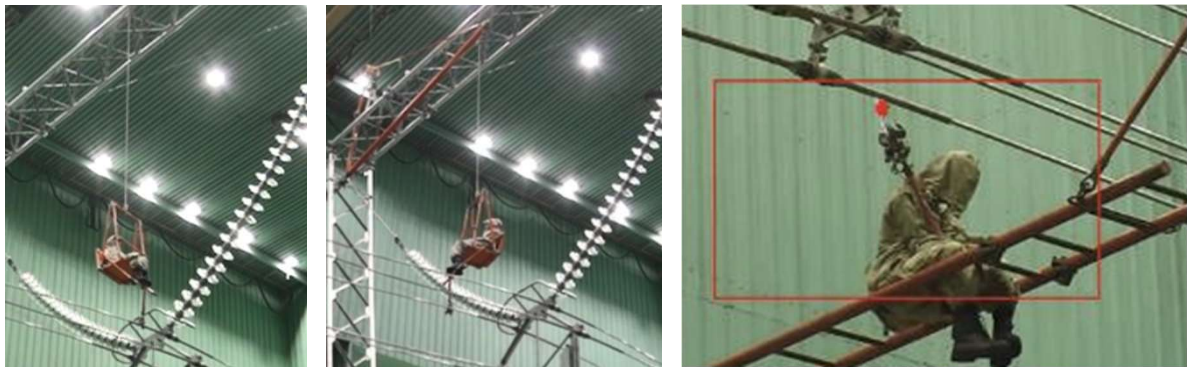
FIGURA 7. Técnicas de linha viva avaliadas para manutenção da torre LPNE compacta
