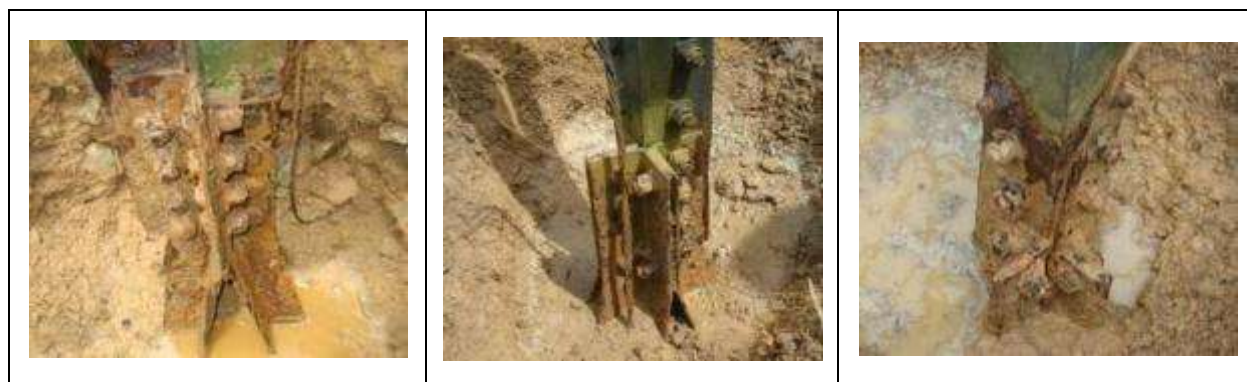
Figura 5 – Aspecto visual do aço galvanizado enterrado de algumas torres inspecionadas em Furnas.
