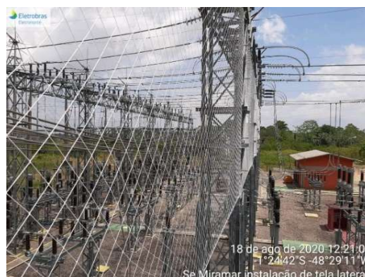
FIGURA 12a e 12b – Estrutura telada aérea colocada para contenção de linhas de pipas
