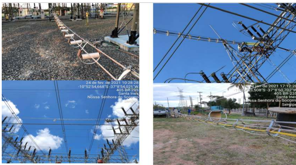
Figura 6- Fotografias ilustrando o Túnel LC ainda no chão e, na sequência instalado e sendo utilizado pelas equipes.
