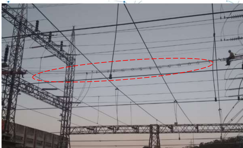
Figura 4 – Imagem do túnel montado e trabalhos em andamento na subestação de Cotegipe.
