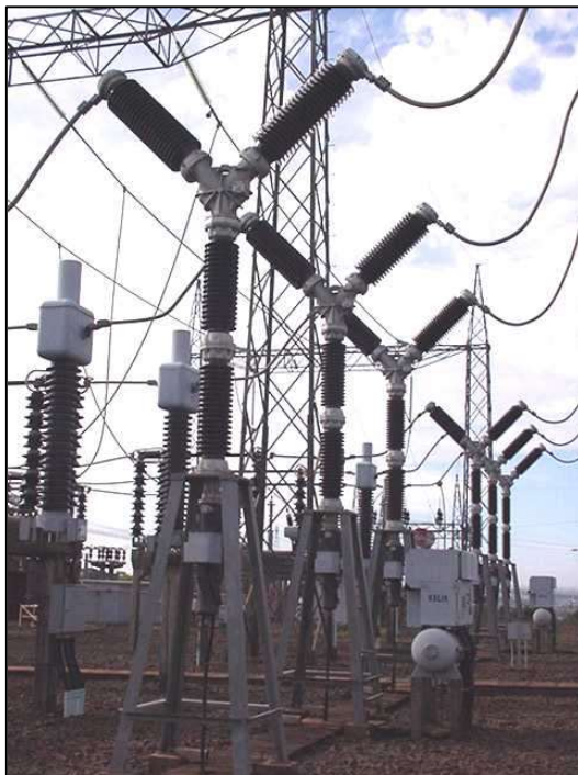
FIGURA 1 – Disjuntor modelo G, instalado na SEMD
