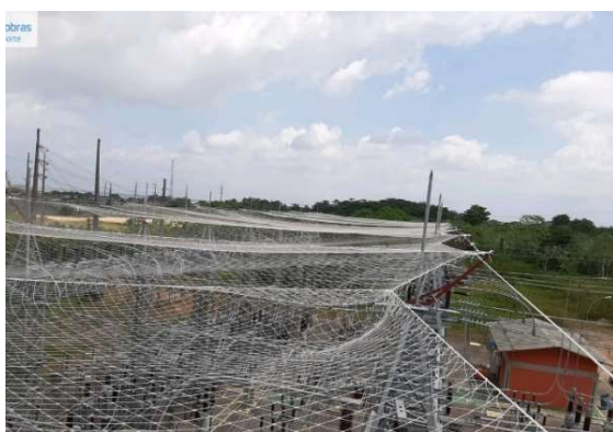
FIGURA 12a e 12b – Estrutura telada aérea colocada para contenção de linhas de pipas
