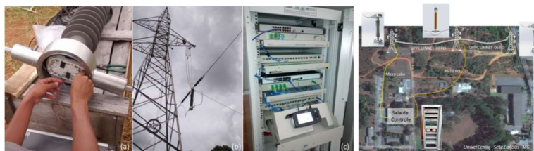
FIGURA 2 - Construção da LAS na UniverCemig: (a) base do novo isolador óptico e elétrico 138 kV, (b) instalação do arranjo com o novo condutor OPPC; (c) rack com as terminações das fibras ópticas e os equipamentos da rede óptica, e (d) foto aérea dos elementos instalados da LAS.
