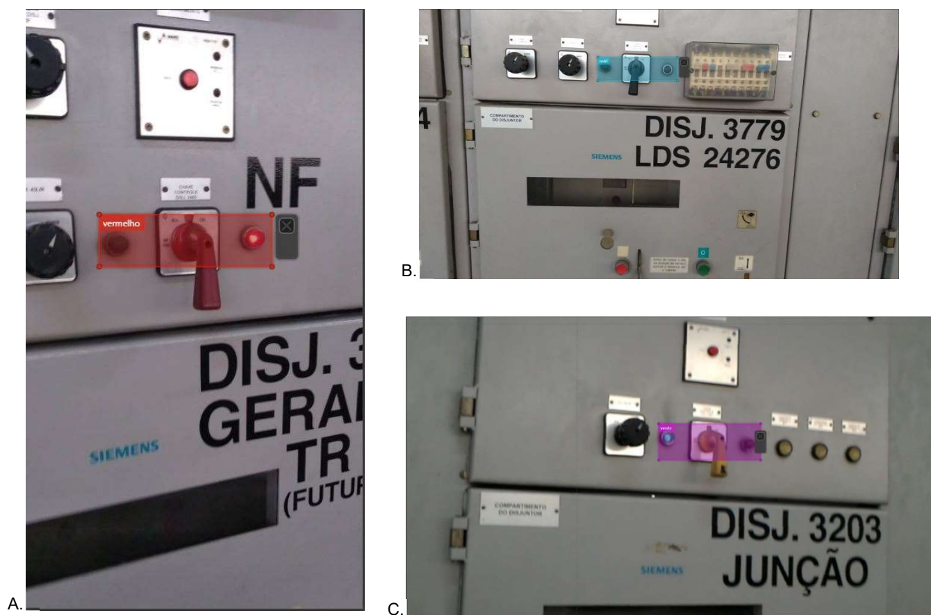
Figura 2 - A - Disjuntor com status vermelho ligado (aberto); B - Disjuntor com não-status (não funcionando); C - Disjuntor com status verde ligado (fechado)
