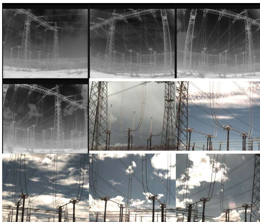
Figura 6 - Imagens térmicas e RGB de ativos em Nova Ponte – MG Fonte: [7]
