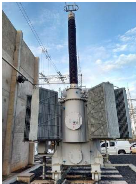
Figura 8 - reator instalado em Itumbiara
