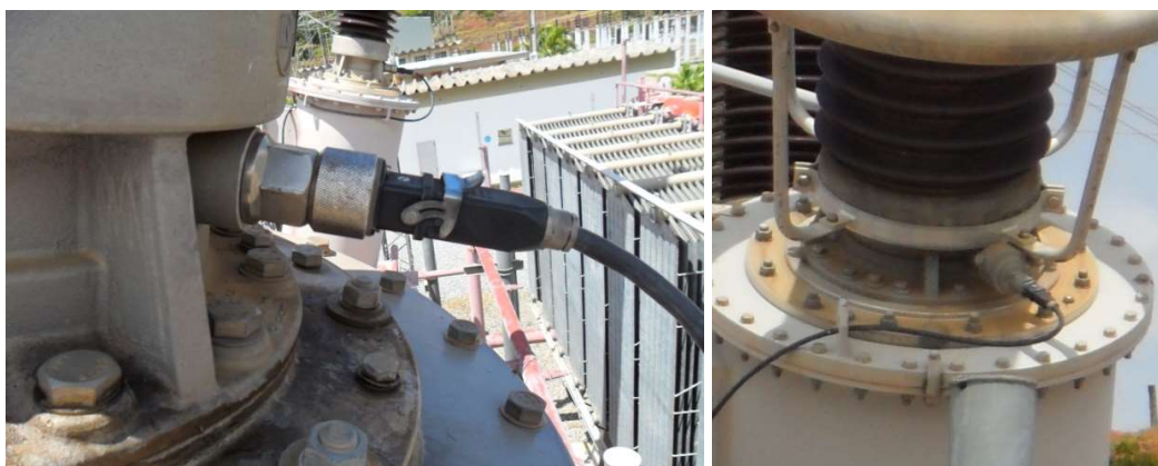
Figura 05: Detalhe dos adaptadores de tap utilizados no sistema de monitoração de buchas BM
