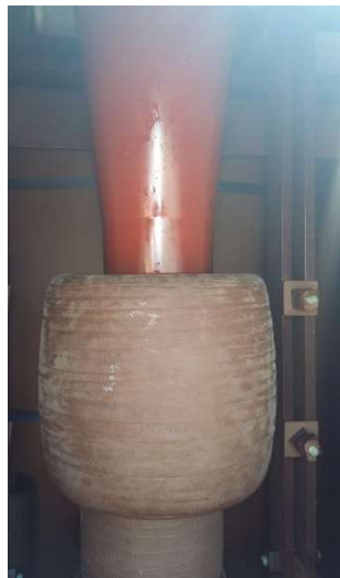
Figura 13 - shield anti corona instalado na bucha
