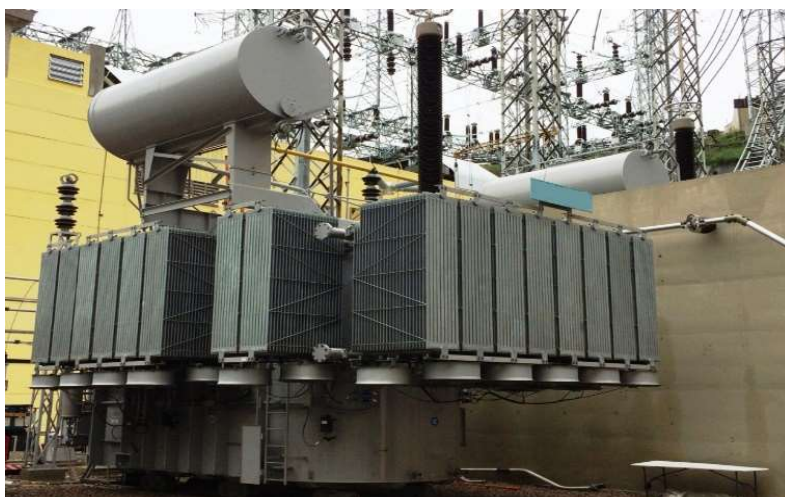
Figura 4: Transformador de potência monofásico de 200MVA, 500/\sqrt{3} / 138/\sqrt{3} / 13,8 kV instalado em uma subestação.
