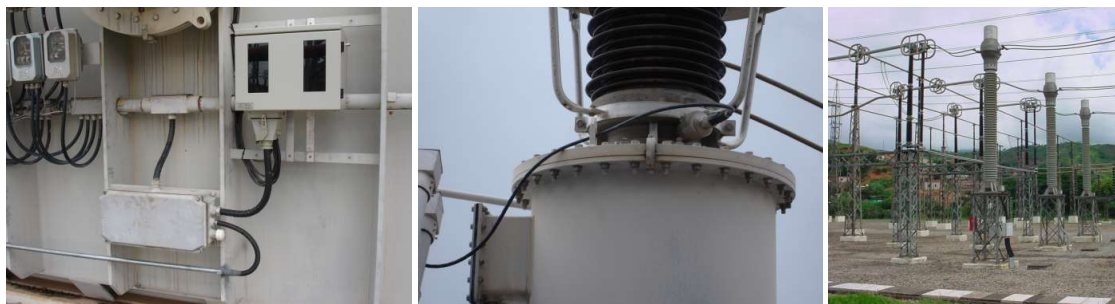
Figura 04: Detalhe das instalações do Sistema de Monitoração realizadas na SE Mesquita, da Cemig
